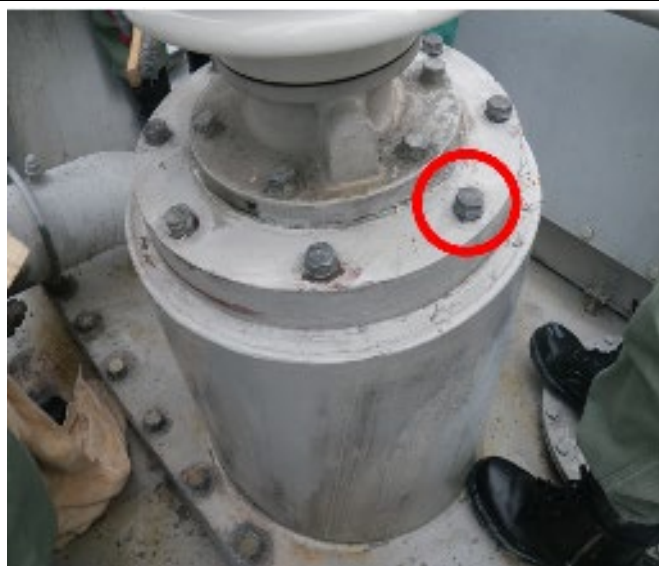
変圧器一次ブッシングポケット
